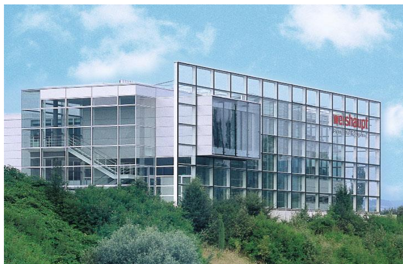
Weishaupt | Bâtiment de formation et administratif à Geroldswil (ZH)
